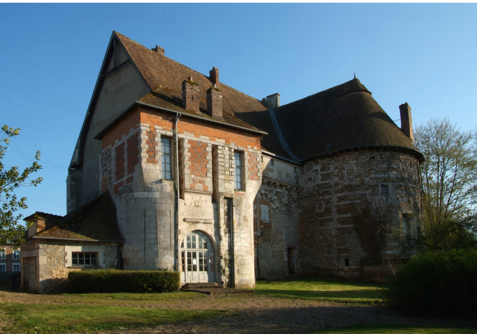
Façade nord du Vieux Château du Neubourg (Cl. Jean-Jacques Walter - Coll. de la mairie du Neubourg)
